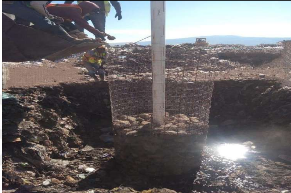
Construcción de pozos de Biogás en el Relleno Sanitario
